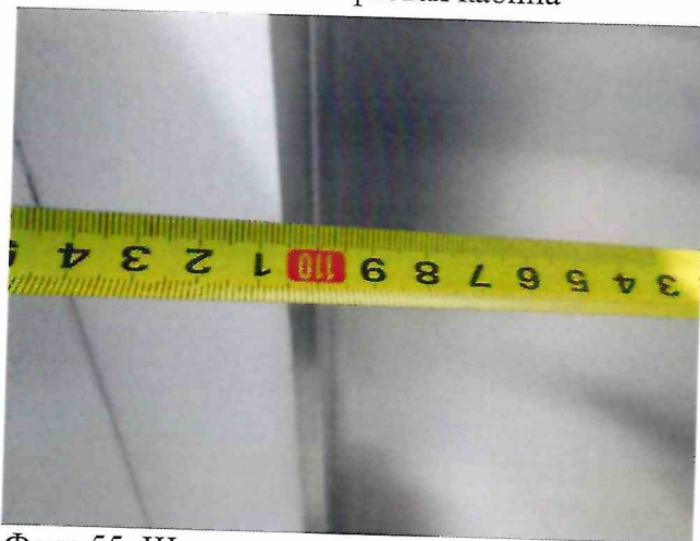
Фото 55. Ширина прохода в лифтовую кабину
