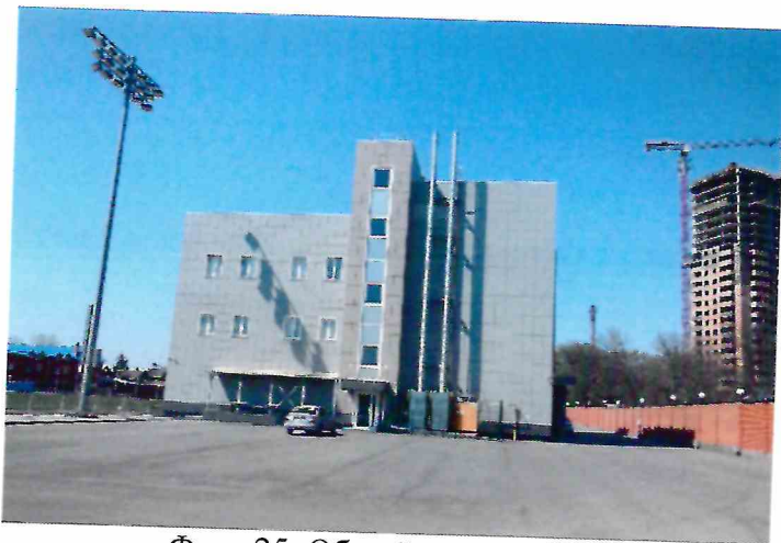
Фото 25. Общий вид здания
