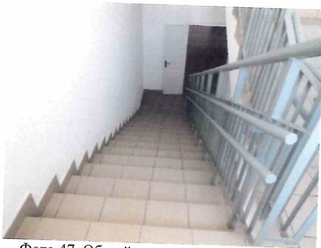
Фото 47. Общий вид лестничного марша
