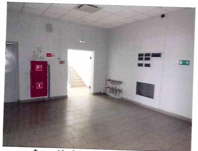
Фото 40. Общий вид коридора
