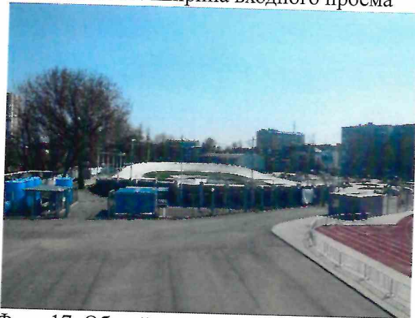
Фото 17. Общий вид на территорию объекта
