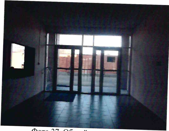
Фото 37. Общий вид коридора
