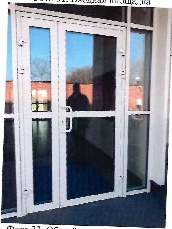
Фото 33. Общий вид входной двери
